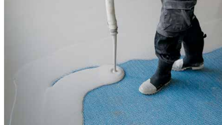
Črna vgradnja izravnalne mase Schönox HS-50 na armirno mrežico Schönox Renotex 3D
