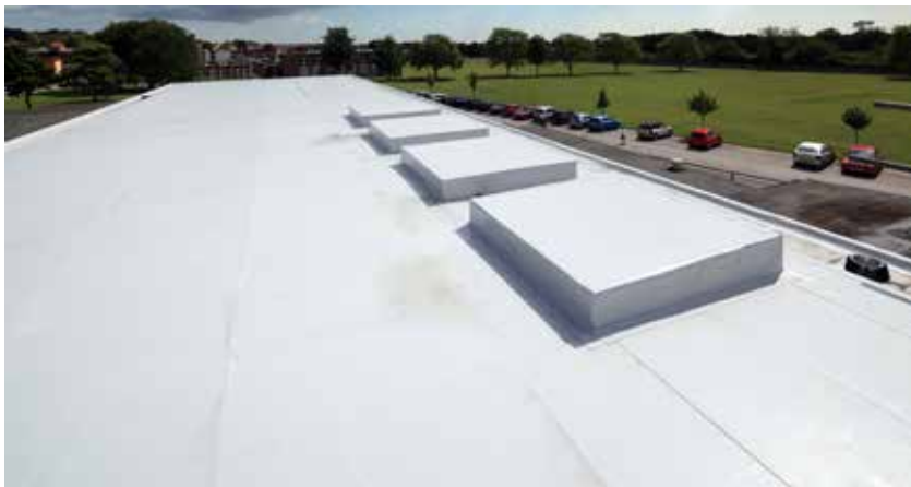
Strešna tesnilna folija iz umetnih mas Sarnafil® TS 77-20 na strehi nove Sikine upravne zgradbe je pomembno prispevala k pridobitvi certifikata DGNB.
