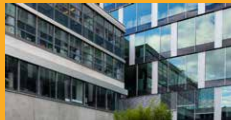
LEPLJENJE IN TESNENJE NA FASADNIH PОВРŠINAH
