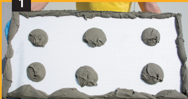
Pritrjevanje EPS izolacijskih plošč Fixing of EPS insulation boards
