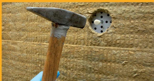
Dodatno pritrdjevanje MW izolacijskih plošč – sidranje Additional fixing of MW insulation boards – anchoring
