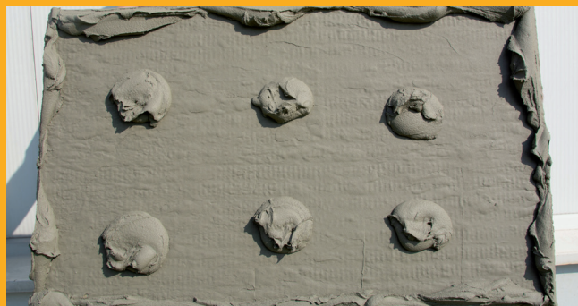
Pritrjevanje MW izolacijskih plošč Fixing of MW insulation boards
