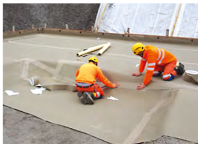
Prikaz predhodno nameščenega sistema SikaProof® A+ (Pre-applied)
