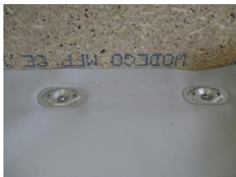
Mehanska pritrnitev s kovinskimi podložkami
