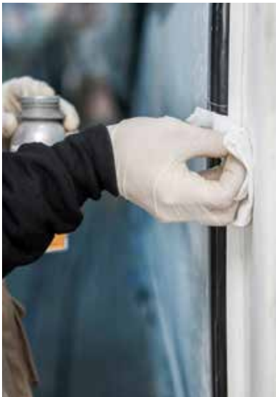
Slika 5: Predpriprava površine s keramičnega robu z aktivatorjem Sika® Aktivator-100
