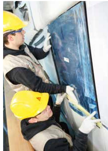
Slika 7: Montaža okenskega panela
