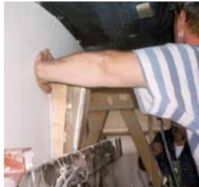
Slika 11: Kobilico pazljivo namestimo
