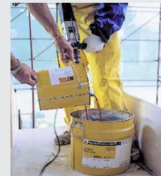
Sl. 6 Premeščanje SikaTransfloor®-352 (SL/ST) v novo posodo
