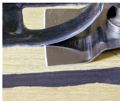
Sl. 49 Odstranjevanje odvečnega materiala SikaFlex®-290 DC PRO iz fug
