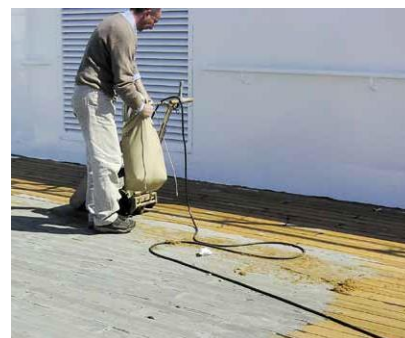
Sl. 20 Brušenje tikove palube
