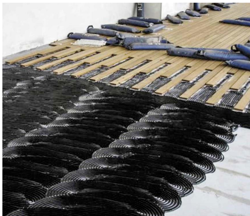
Sl. 14 Polaganje in obteževanje tikovih deščic
