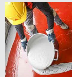
Sl. 7 Izlivanje SikaTransfloor®-352 (SL/ST) na palubo
