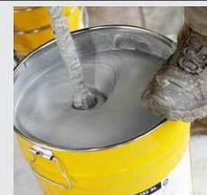
Sl. 5 Mešanje SikaTransfloor®-352
