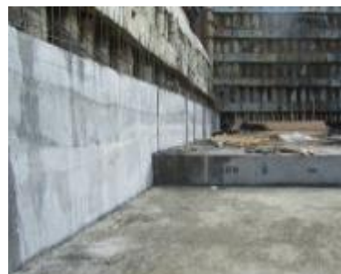
Pilotna stena s sidrišči. Neravna površina zravnanja z malto Sika MonoTop.
