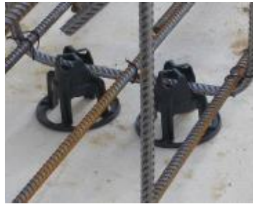
Uporaba enojnih distančnikov z veliko naležno površino in brez ostrih robov.
